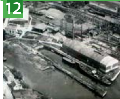
SCHIEPWERF EN DIRECTEURSWONING RIJSDIJK 64
