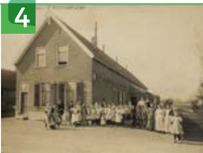
VOORMALIGE CHRISTELIJKE SCHOOL EN ONDERWIJZERSWONING HOOFDSTRAAT 104 EN 111
